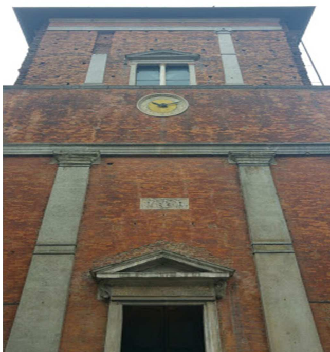
Facciata esterna della Cappella Trivulzio
